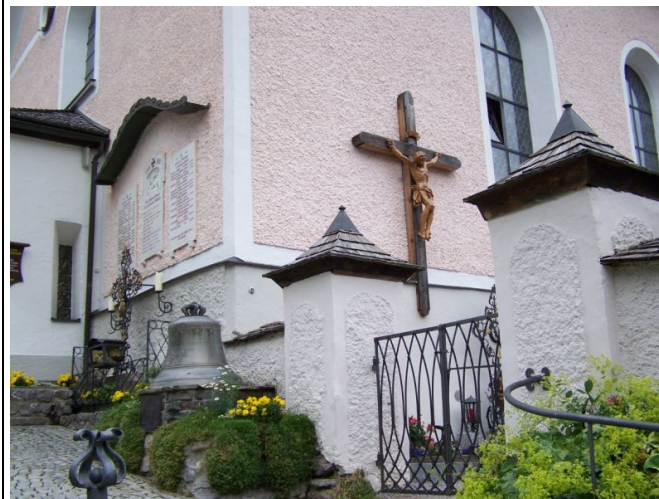
Aufar Calvaire du cimetière contre le mur de l'église
