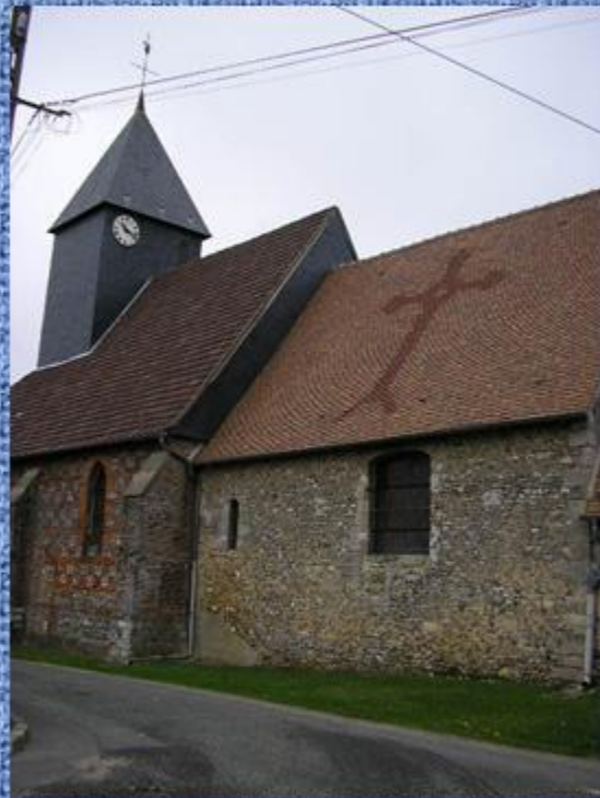
Croix sur la toiture de l'église
