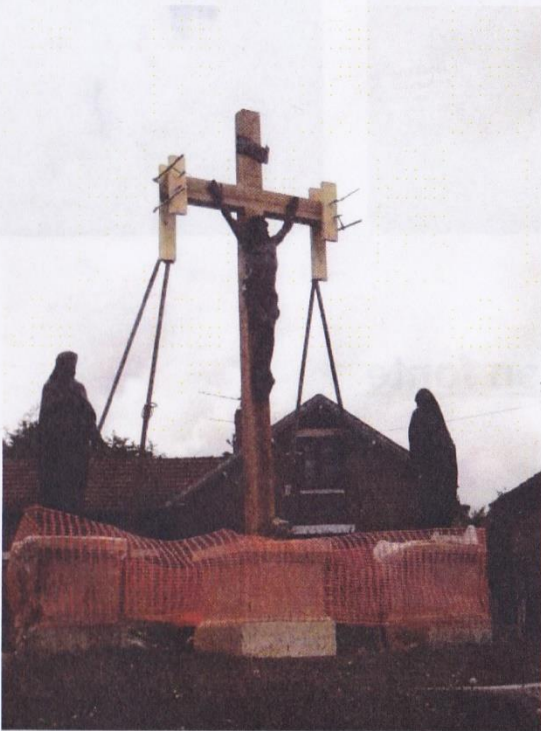
Le calvaire en cours de restauration
