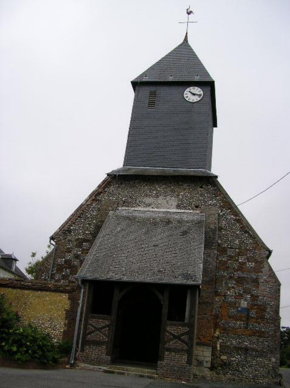
Eglise de Beaumont les Nonains Détail du toit (Canton d'Auneuil)
